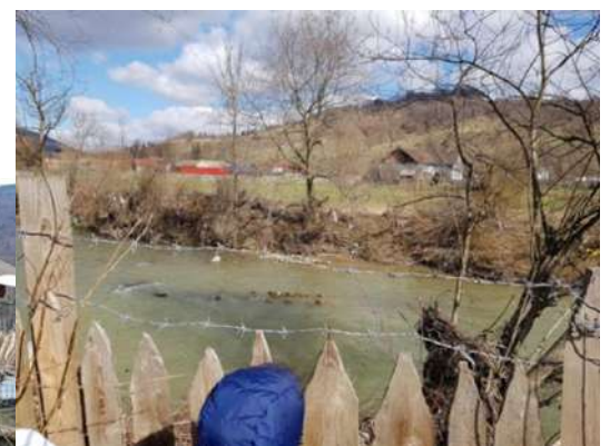
pilonii vechiului pod
